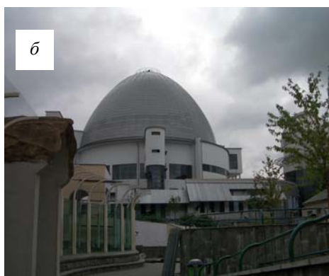
Рис. 6. Параболический железобетонный купол Московского планетария а – до реконструкции (1927-1929) ; б – после реконструкции (2011 г.)
