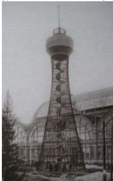
Рис. 5. Водонапорная башня Шухова в форме однополостного гиперboloида вращения
