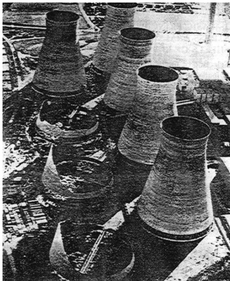
Рис. 20. Общий вид градирен в г. Феррибридж после штормового ветра [30]
