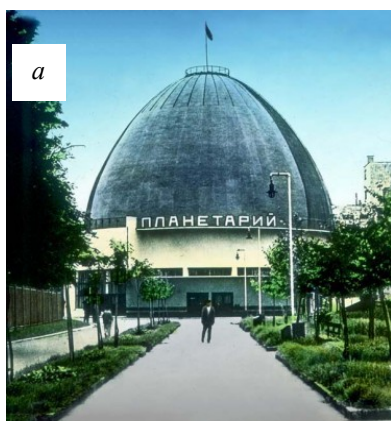
Рис. 6. Параболический железобетонный купол Московского планетария а – до реконструкции (1927-1929) ; б – после реконструкции (2011 г.)
