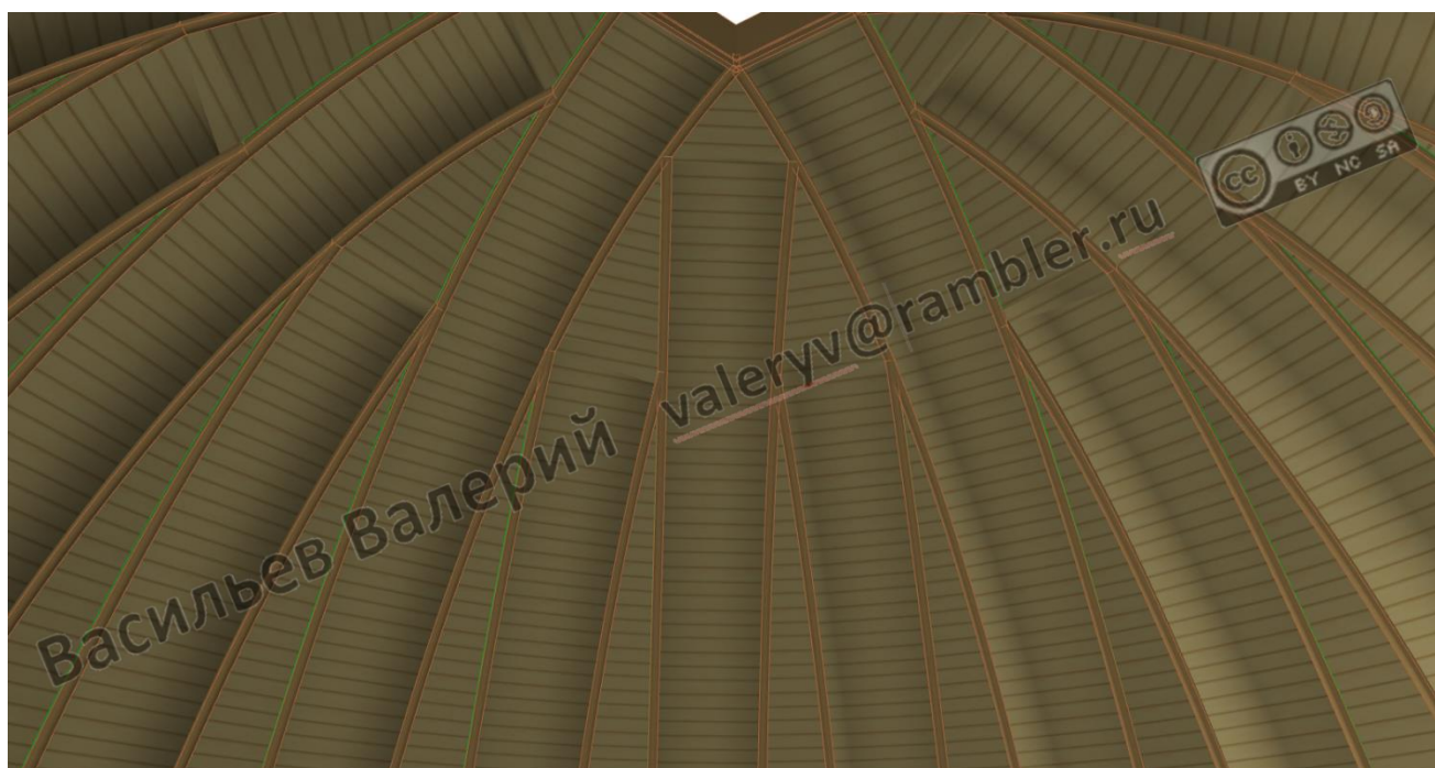
Рис. 13б Дощатая обшивка пятилепесткового купола, вид изнутри на верхнюю боковую часть
