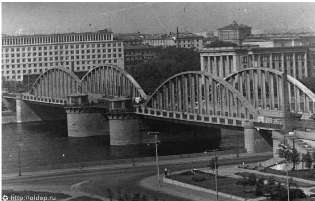
Рис. 6. Мост через Неву с арками из многотрубного трубобетона. Источник: http://oldsp.ru
