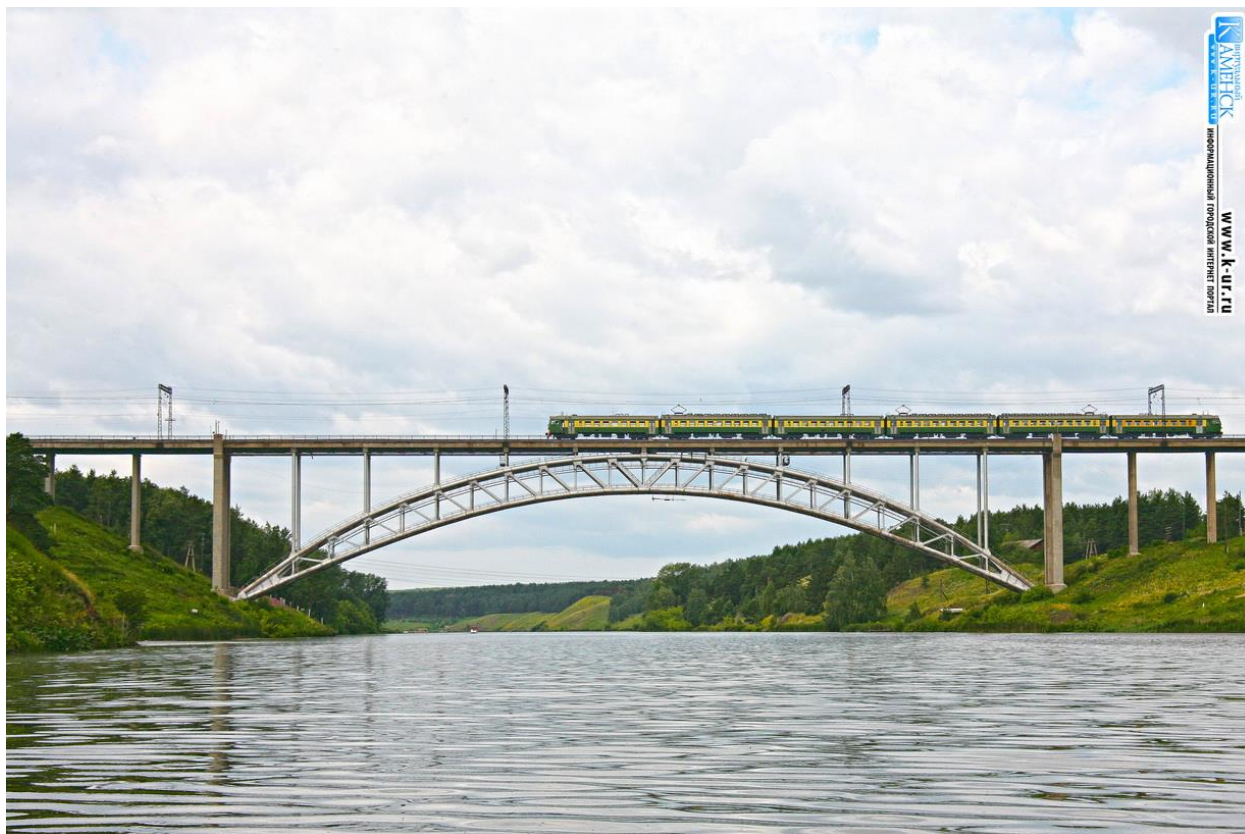
Рис. 7. Железнодорожный мост с арками из трубобетона через реку Исеть. Источник: http://k-ur.ru/images/stories/2013/putevoditel/mostzhd/IMG_6773.jpg
