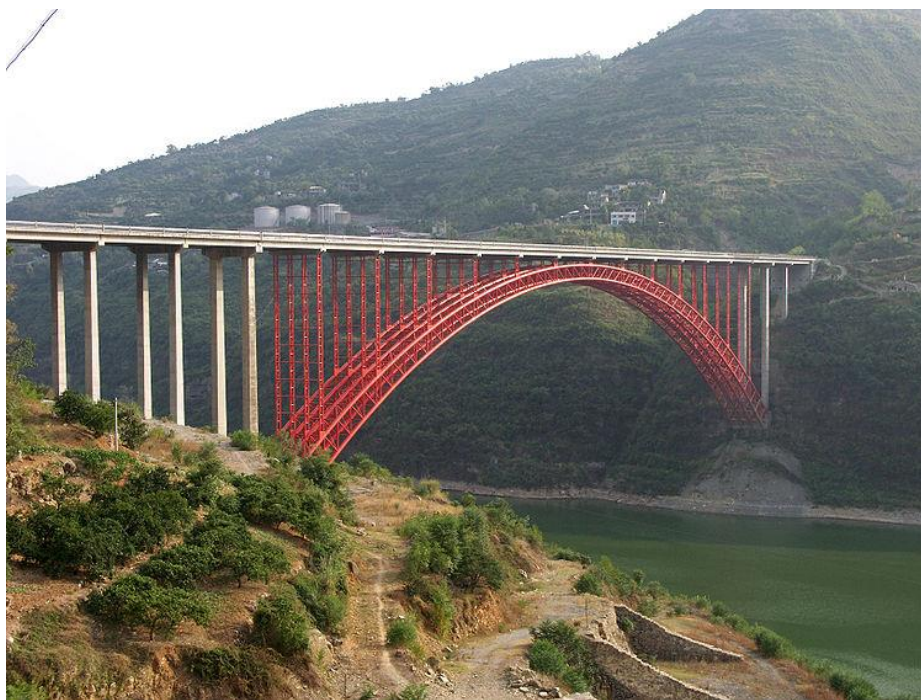
Рис. 12. Мост Fengjie Meixihe с трубобетонными арками. Источник: http://www.highestbridges.com/wiki/index.php?title=Meixihe_Bridge
