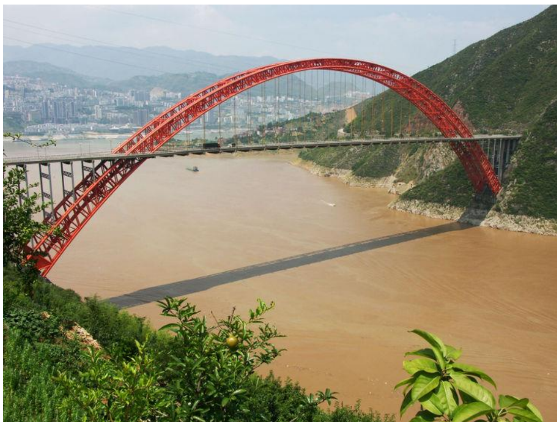
Рис. 10. Трубобетонный арочный мост Chongqing Wushan Bridge. Источник: http://www.highestbridges.com/wiki/index.php?title=Wushan_Yangtze_River_Bridge
