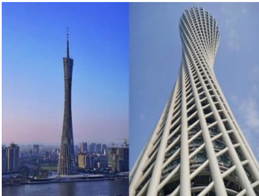
Рис. 4. Криволинейная форма башни, полученная из прямолинейных трубобетонных элементов. Источник: http://mediasat.info/2015/04/28/canton-tower/
