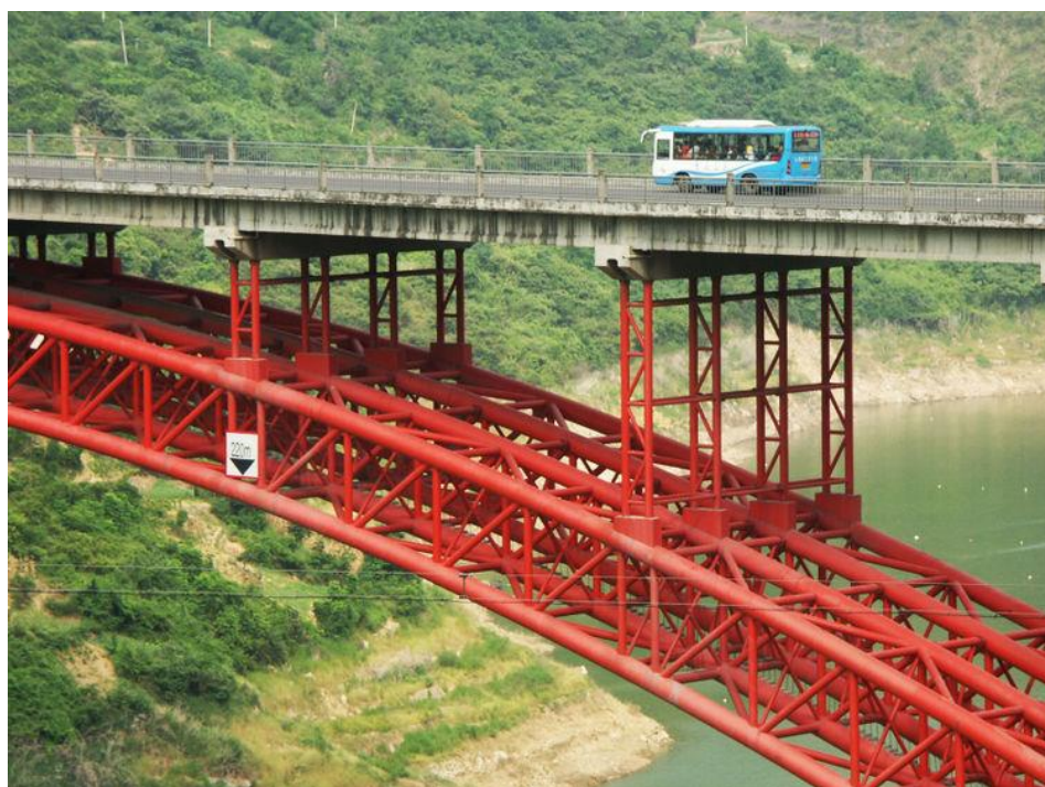
Рис. 13. Конструкция арок и надарочной части моста Fengjie Meixihe. Источник: http://www.highestbridges.com/wiki/index.php?title=Meixihe_Bridge
