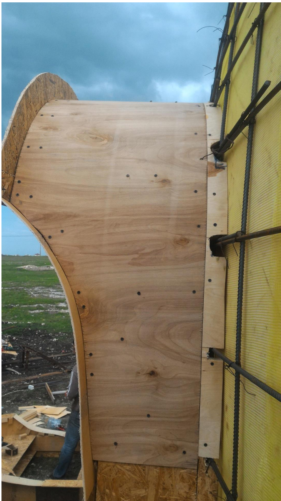
Примыкание оконной опалубки к куполу .
