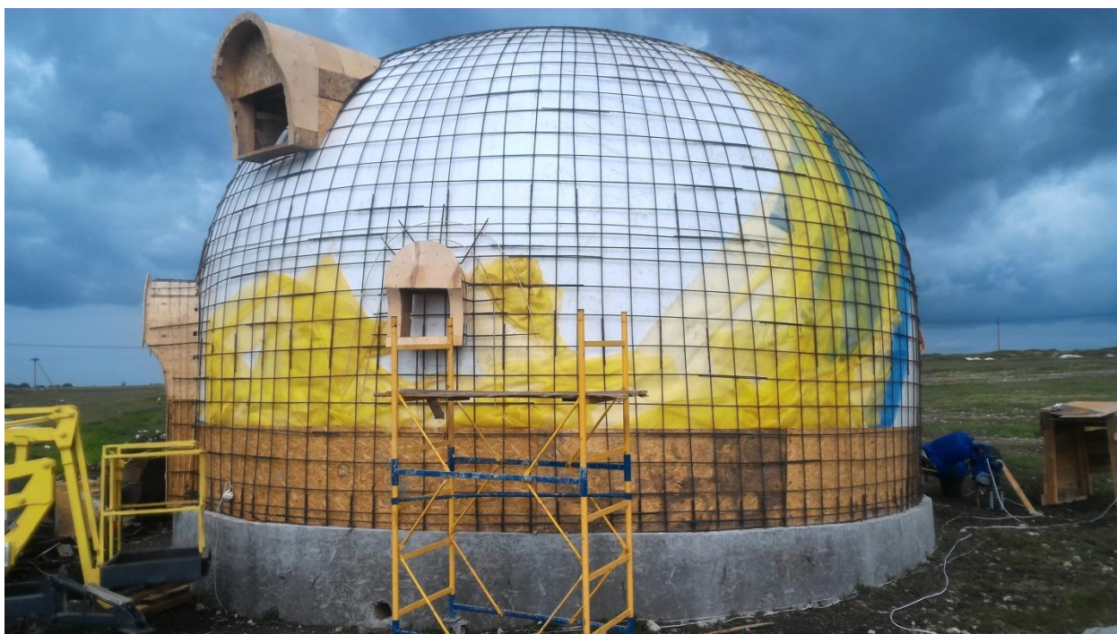
После полного завершения купола (силовой купол+ППУ+ внешний слой торкретбетона) опалубка окон и двери демонтируется .
