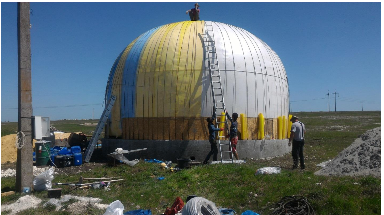
Установка штукатурной сетки между оболочкой и арматурным каркасом для избежания сползания бетона при торкретировании.
