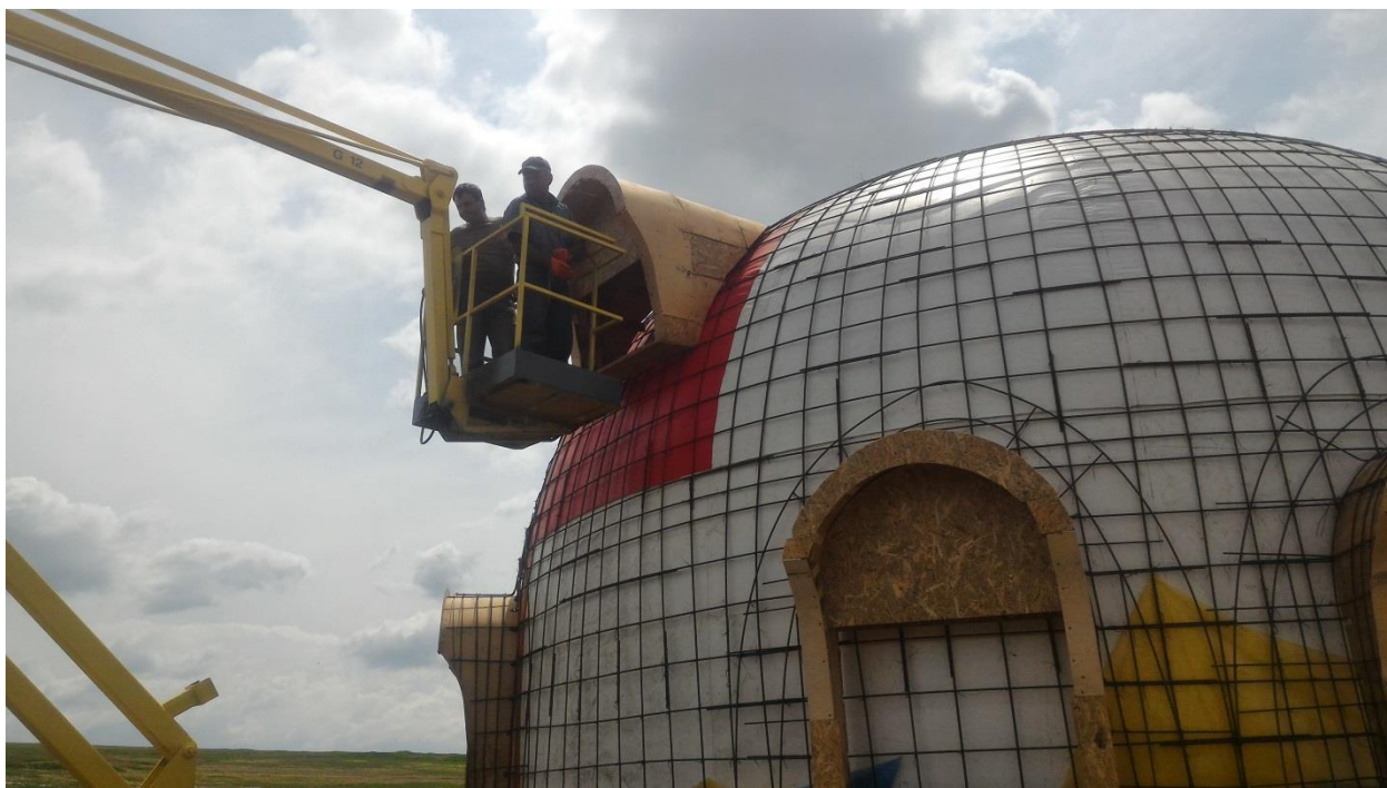
Установка опалубки окна второго этажа.
