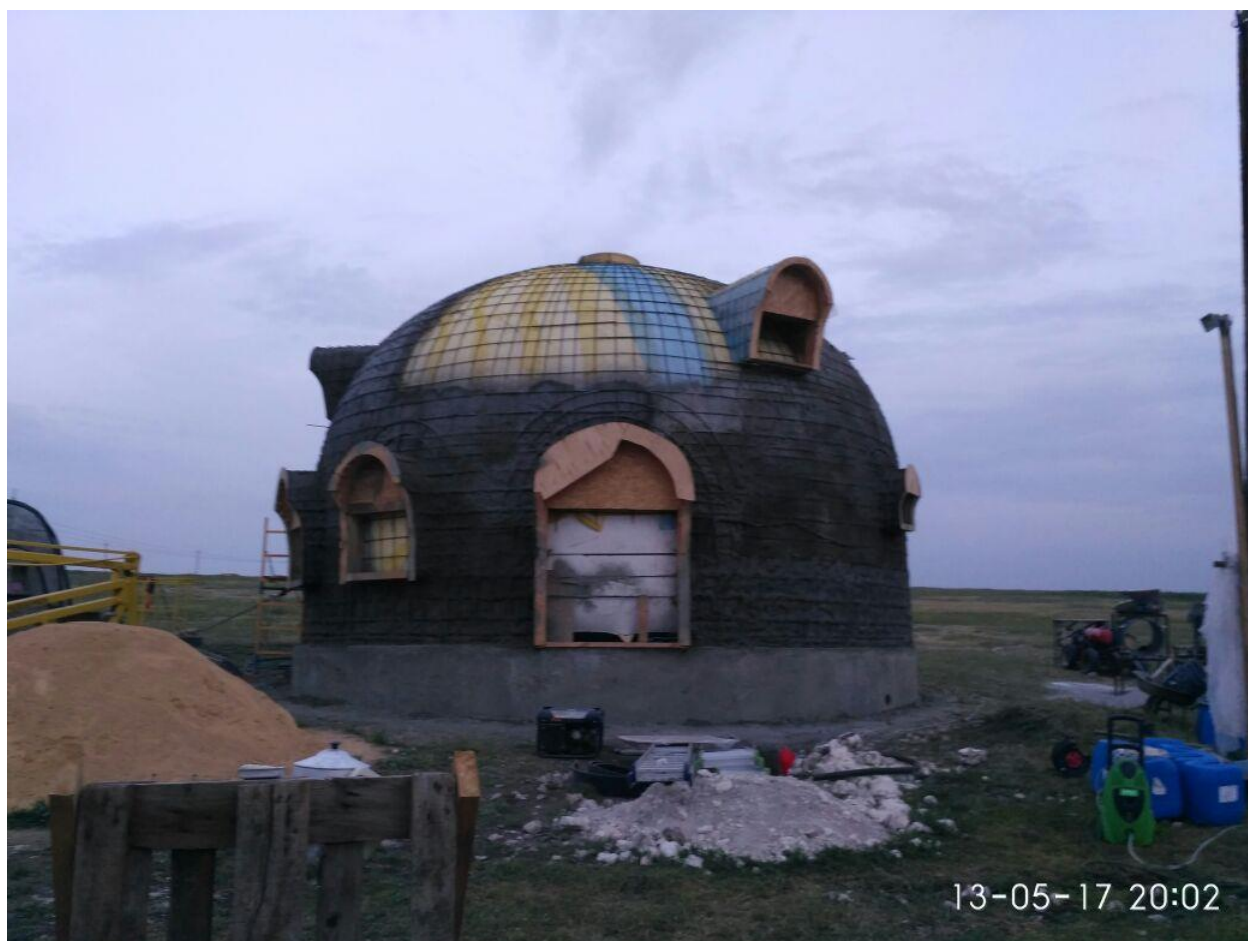
Начало торкретбетонирования.
