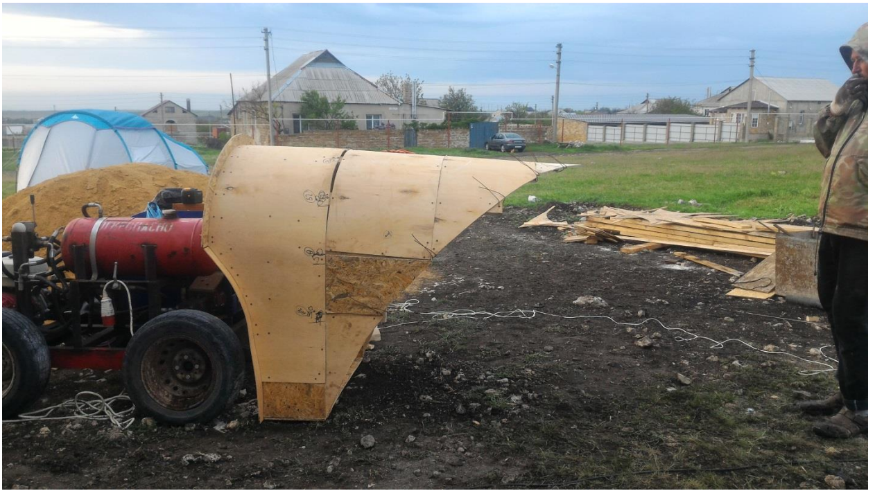
Опалубка окна второго этажа.
