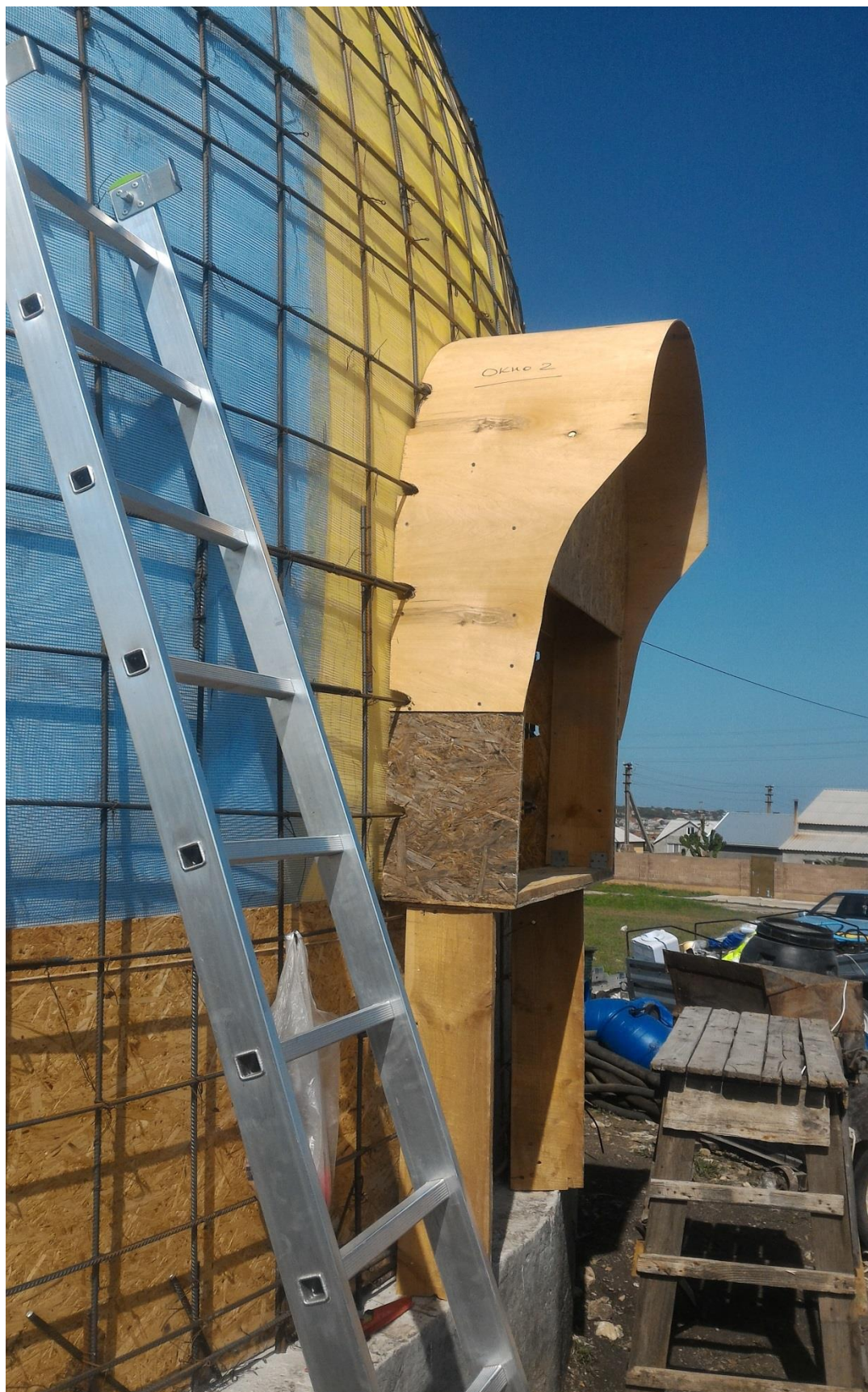
Примерочная установка опалубки оконного проёма.
