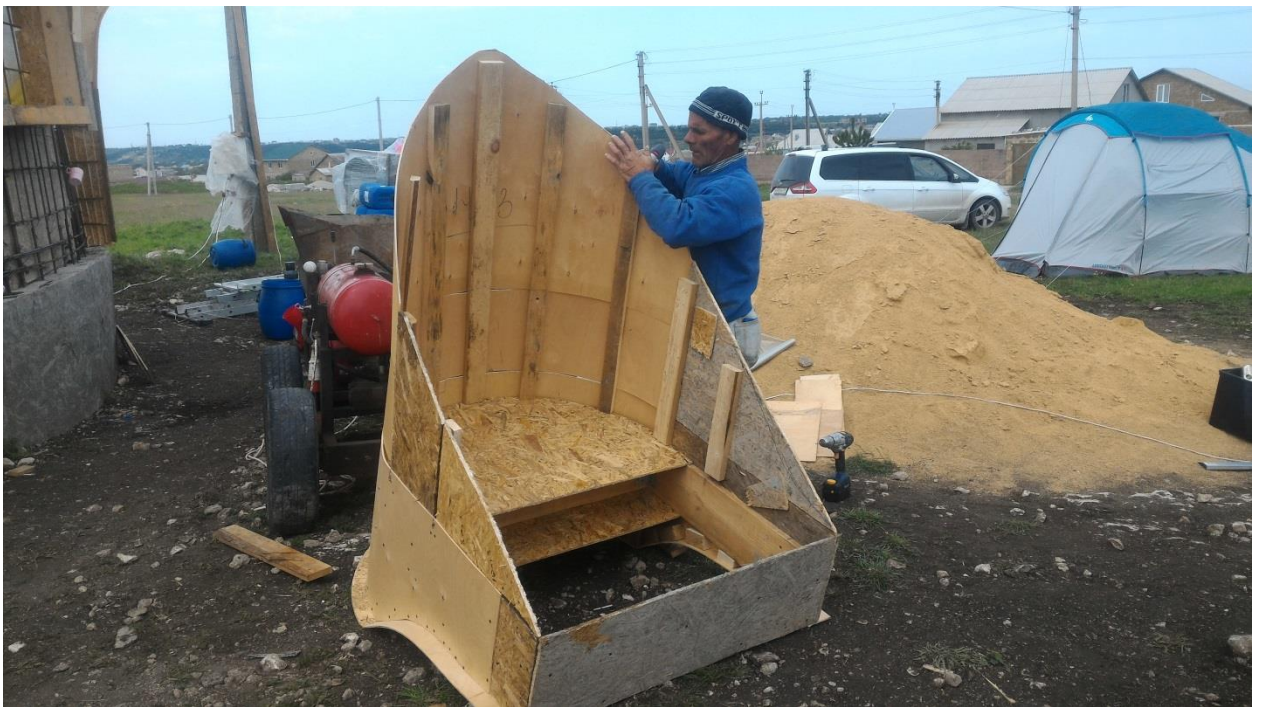
Внутренняя структура опалубки. Рёбра жесткости.
