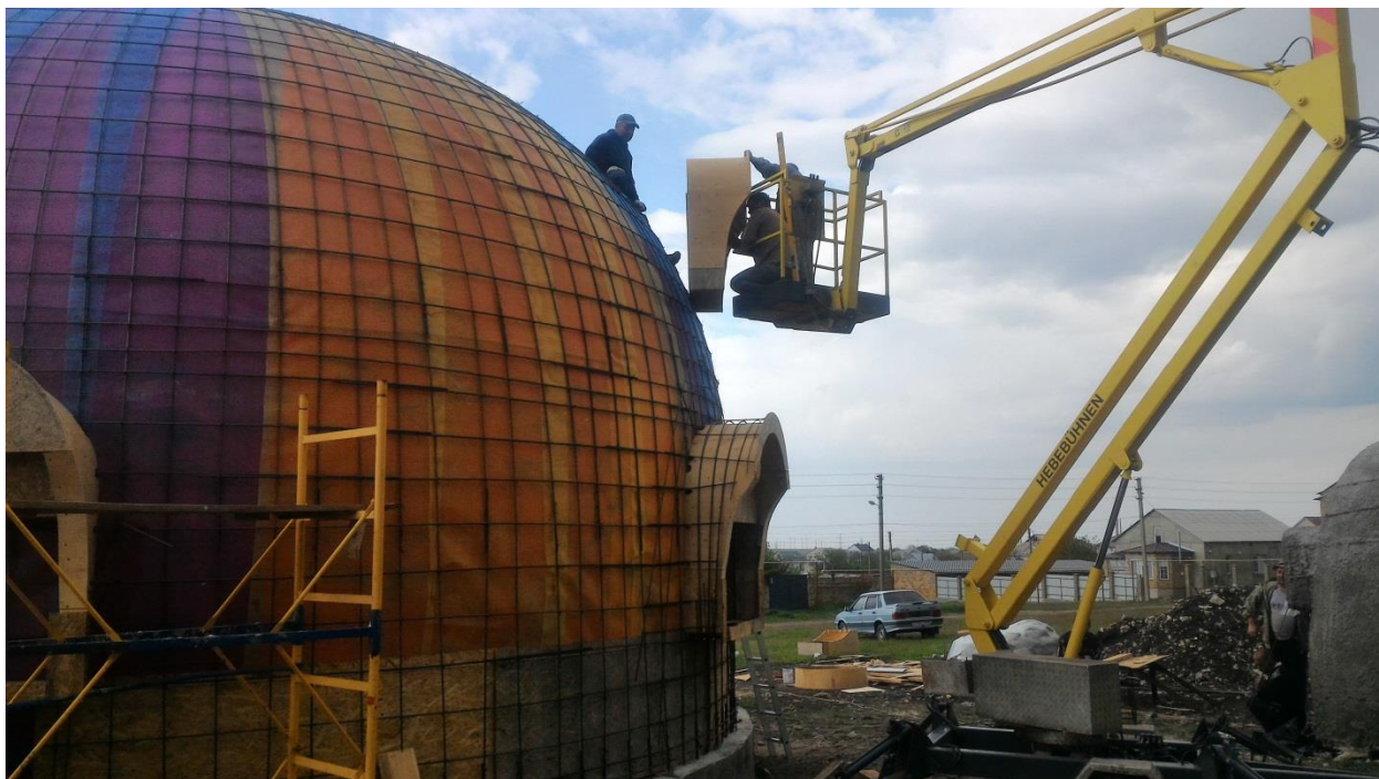
Снятие замеров для определения, дуги примыкания опалубки окна второго этажа к поверхности купола.
