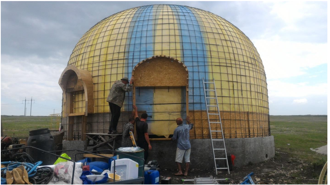
Монтаж дверной опалубки.
