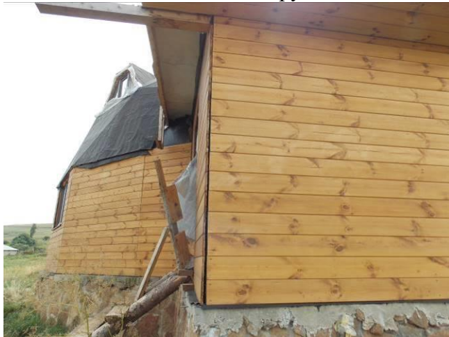
Фото № 19 – облицовка наружных стен
