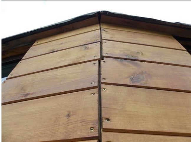
Фото № 13 – облицовка наружных стен
