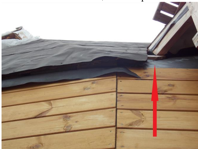
Фото № 21 – отсутствует устройство вентиляционной прослойки
