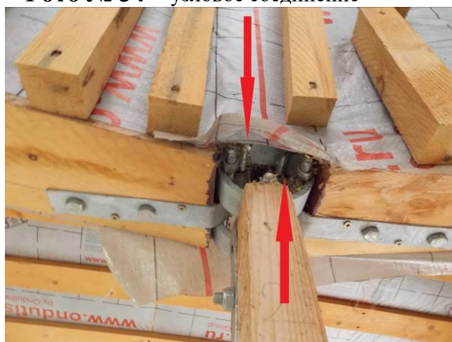
Фото № 34 – узловое соединение
