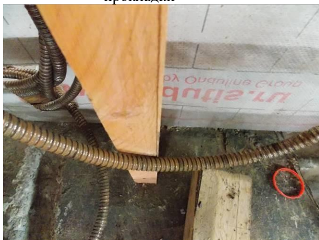
Фото № 31 – нет гидроизоляционной прокладки
