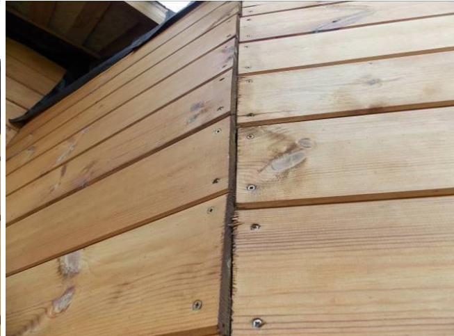
Фото № 14 – облицовка наружных стен
