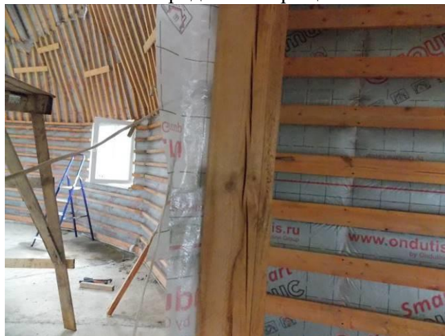
Фото № 44 – продольная трещина
