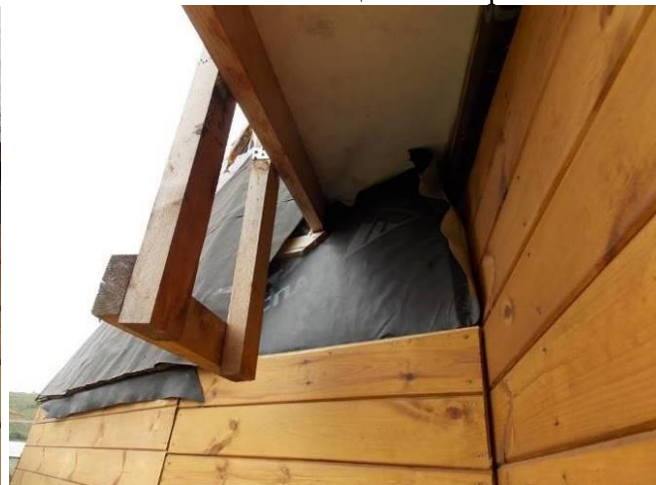
Фото № 22 – отсутствует устройство вентиляционной прослойки
