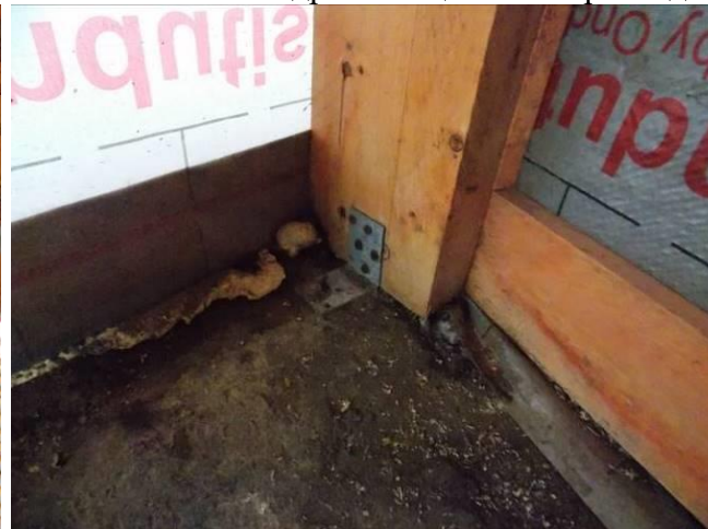
Фото № 30 -нет гидроизоляционной прокладки
