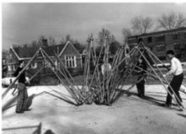
Рис. 2: Летающий стручок. Вашингтонский университет, Сент-Луис, 1953; Разборная геодезическая структура.
