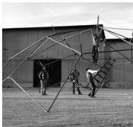
Рис. 2: Летающий стручок. Вашингтонский университет, Сент-Луис, 1953; Разборная геодезическая структура.
