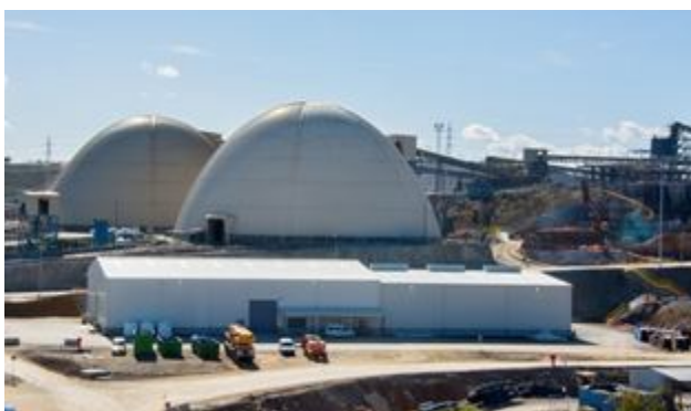
Рис. 17. Воздухоопорные купола [13]
