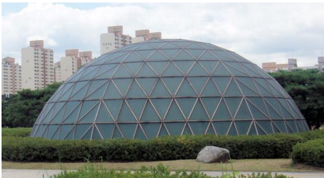
Рис. 1.7. Купол Чивитта с ромбическими панелями широтной раскладки диаметрами 60 м (расход алюминия 16 \text{ кг/м}^2 ) и 72 м (расход алюминия 18,6 \text{ кг/м}^2 ), имеющие местные стержневые усиления (СССР).
