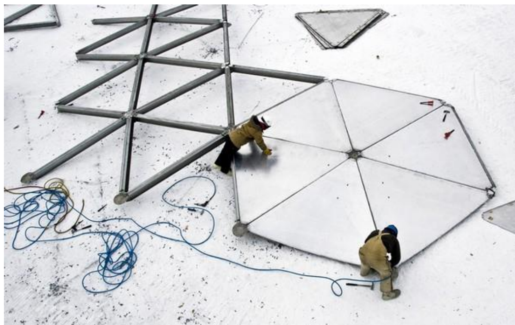
Рис. 1.17. Узлы соединения элементов купола в Антарктиде.
