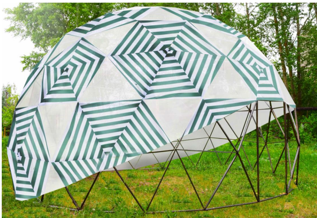
Рис.5.12. Тентовые купольные павильоны пролетом в парке г.о. Рузаевка с узлами варианта II с опорами одного уровня: а - стальной каркас типового навеса 8.1 м; б - тентовый купол 7,2 м.
