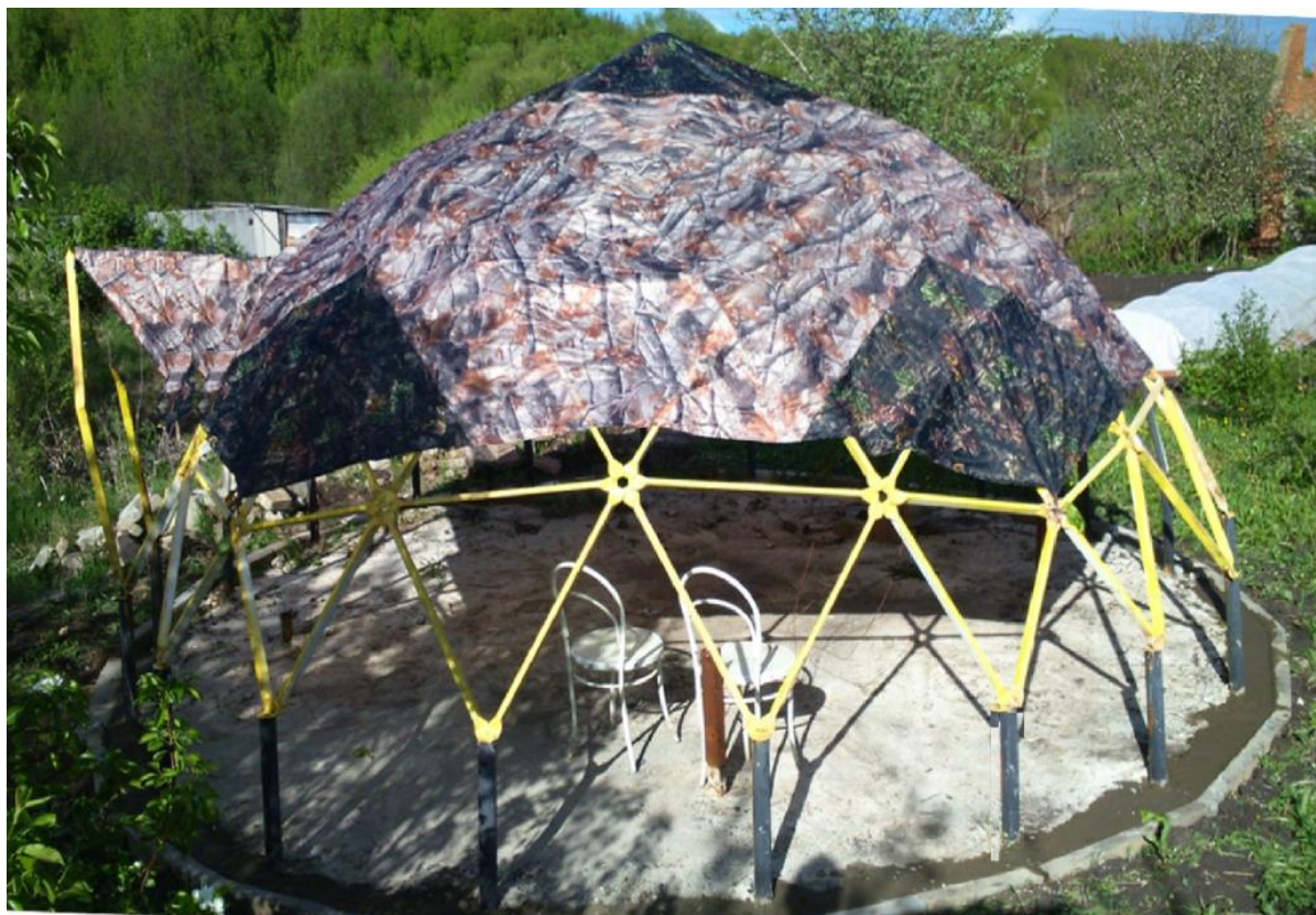
Рис.5.11. Легкий тентовый купол-навес пролетом 6 м с узлами купола параграфа 5.3.
