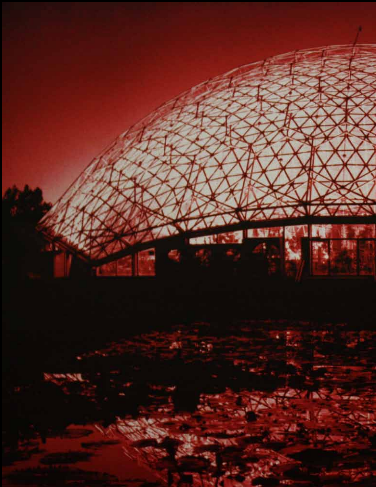
ORTO BOTANICO SHAW, ST. LOUIS (MISSURI), 1960. CUPOLA GEODETICA A DOPPIA ORDITURA DEL DIAMETRO DI 100 METRI. I PANNELLI TRASPARENTI DI MATERIALE ACRILICO CONSENTE LA REALIZZAZIONE DI UN HABITAT CONTROLLATO INTEGRAMENTE.
