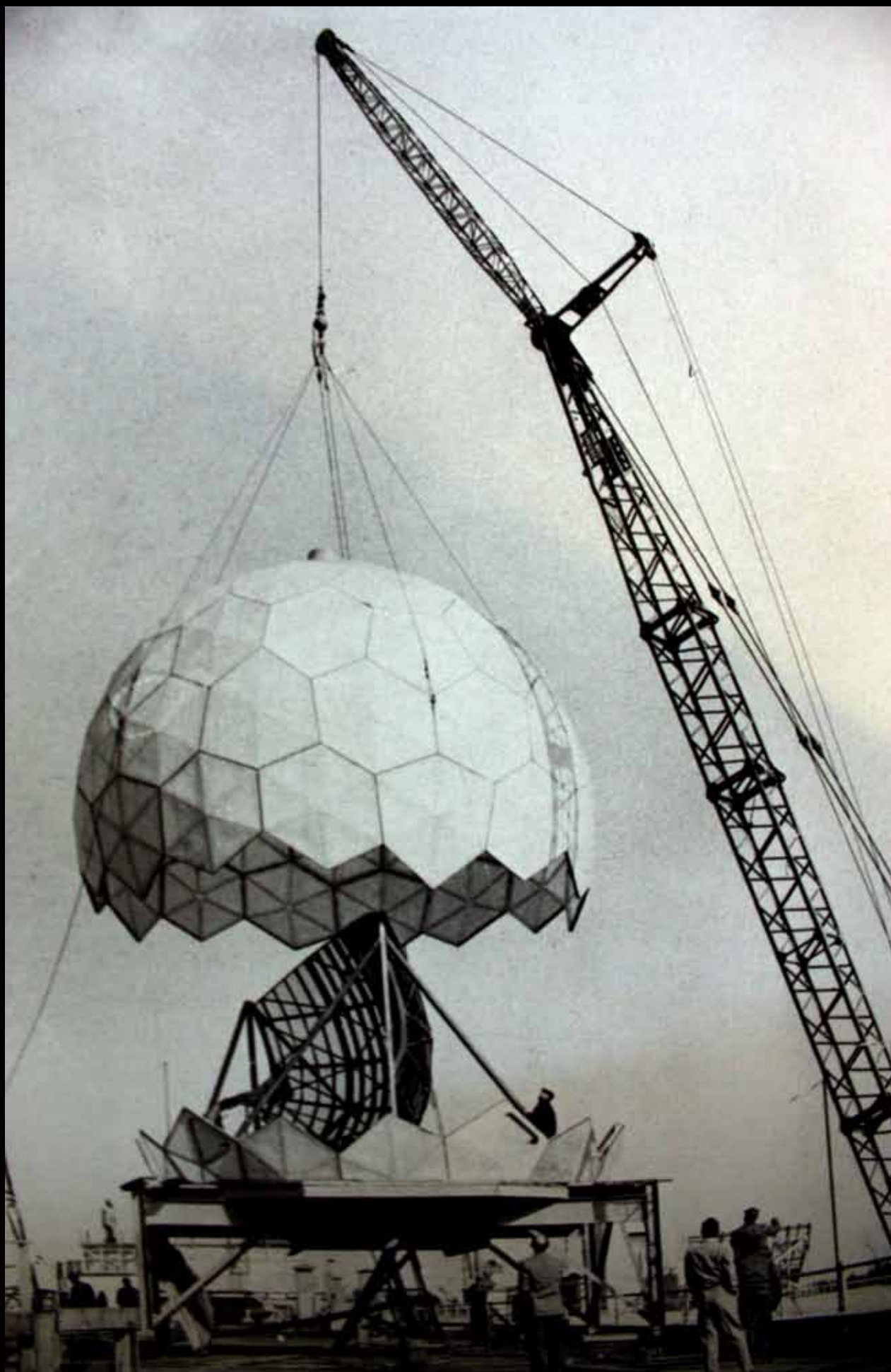
UNA RADOM DURANTE IL MONTAGGIO, MASSACHUSETTS INSTITUTE OF TECHNOLOGY, 1955
