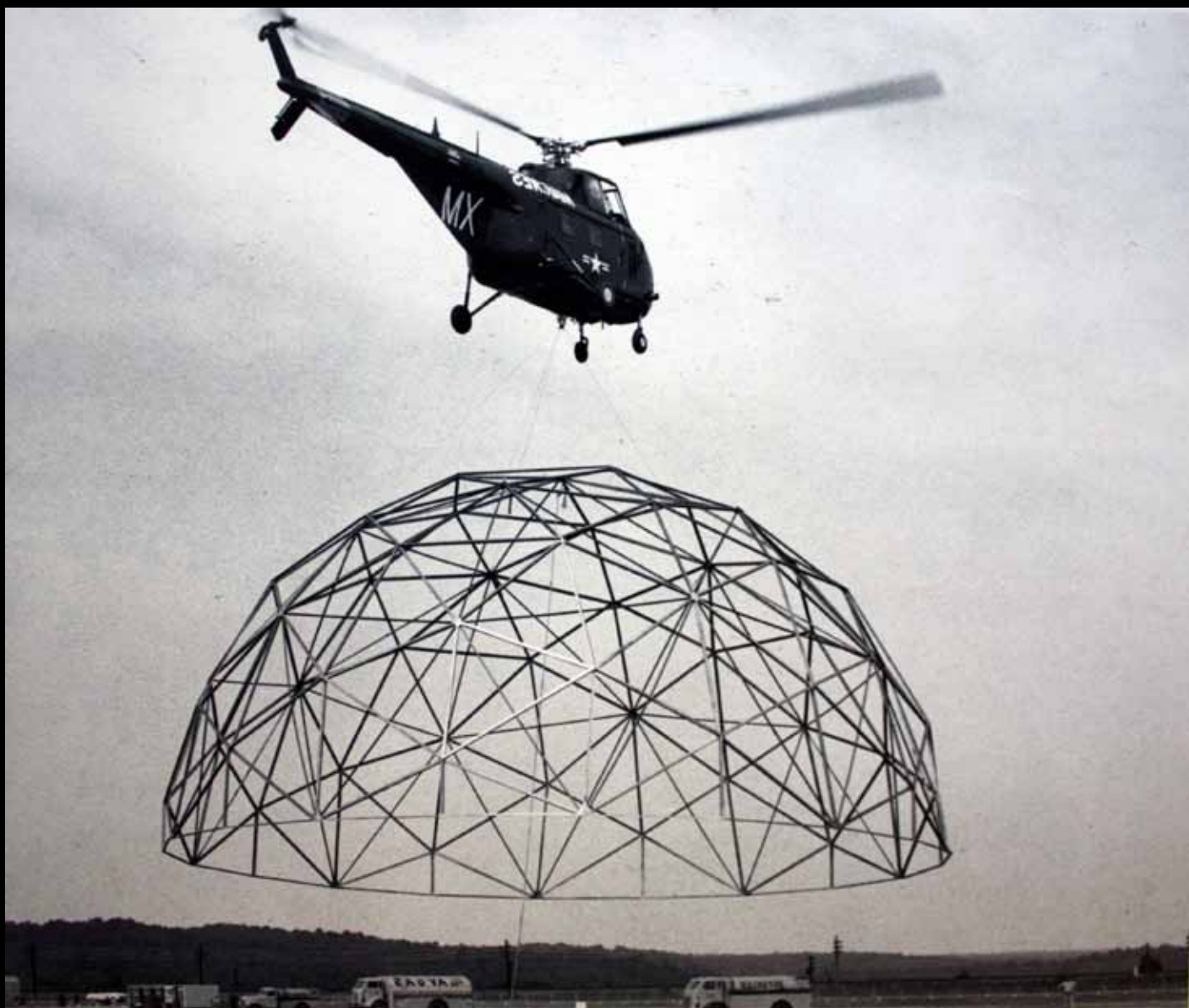
UN ELICOTTERO DEL CORPO DEI MARINE DEGLI USA SOLLEVA UNA CUPOLA DEL DIAMETRO DI 16,5 METRI CIRCA, 1954
