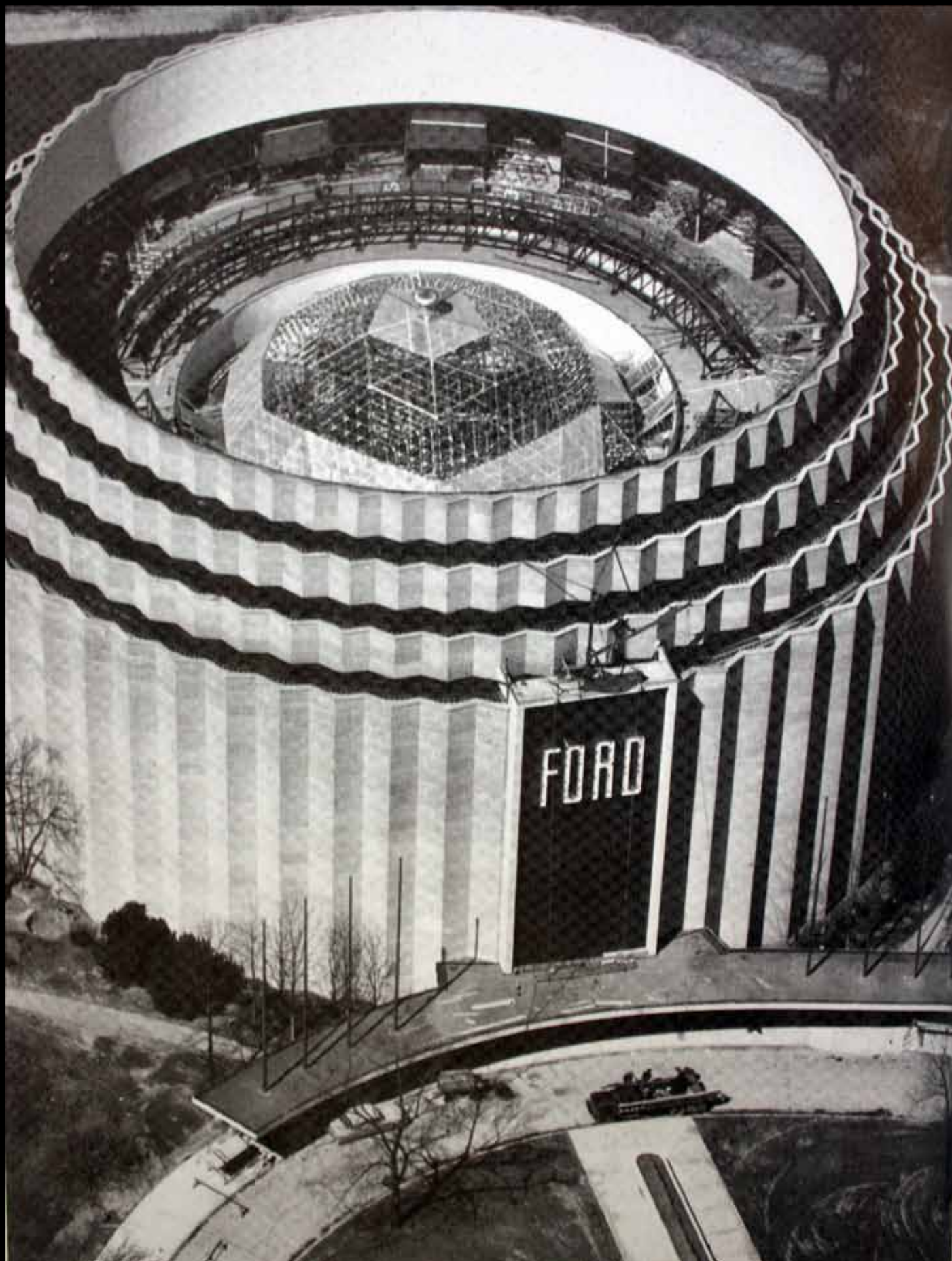
FORD-ROTUNDA, CHICAGO, 1933. CUPOLA DEL DIAMETRO DI 28,5 METRI E DEL PESO DI 85 TONNELLE. QUESTA CUPOLA, REALIZZATA PER CELEBRARE IL CINQUANTESIMO ANNIVERSARIO DELLA COMPAGNIA, SEGNA L'INIZIO DELLA PRODUZIONE SU SCALA INDUSTRIALE DELLE STRUTTURE GEODETICHE. VENNE REALIZZATO QUESTO TIPO DI CUPOLA PERCHÈ NON SAREBBE STATO POSSIBILE COLLOCARE UNA COPERTURA DI TIPO TRADIZIONALE A CAUSA DEL PESO E ANCHE PERCHÈ SAREBBERO STATI TROPPO LUNGI I TEMPI DI COSTRUZIONE.
