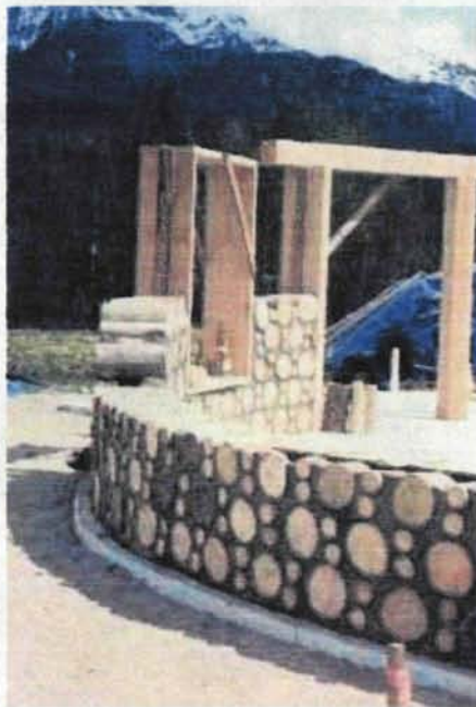
Рисунок 2.92 - Строительство дома по технологии cordwoodmasonry
