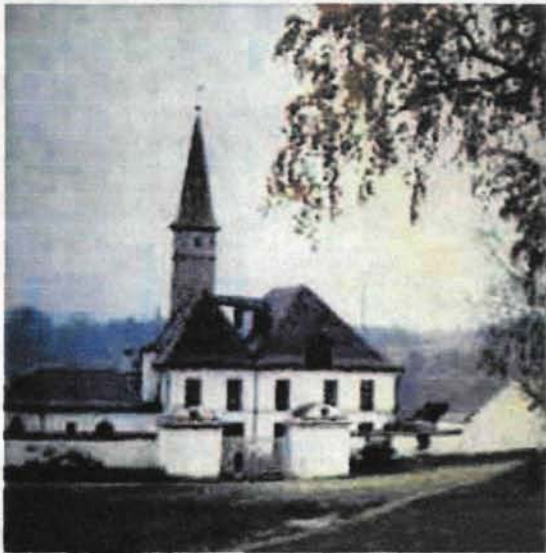
Рисунок 2.99- Приоратский дворец в Гатчине, построенный в технике землебита (1797—1799 г.г. архитектор А.Н.Львов).
