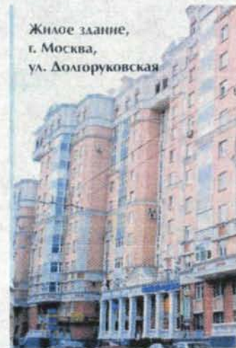
Рисунок 2.89- Пример использования многослойного «мокрого» фасада системы «Сенарджи»
