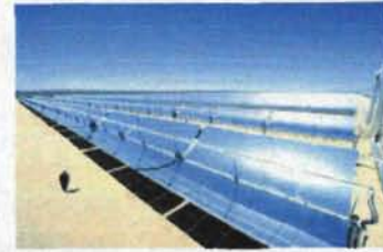
Рисунок 2.116- Плоский гелиоконцентратор
