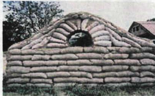
Рисунок 2.100- Возведение стен по технологии earthbags .
