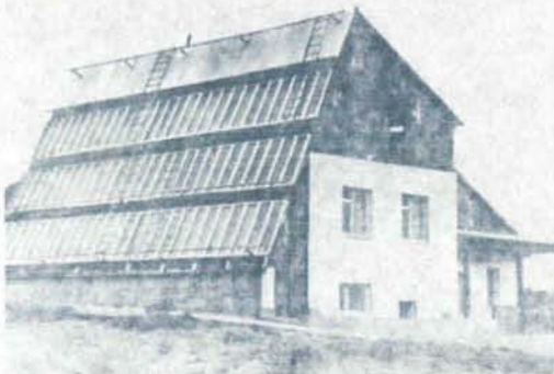
Рисунок 1.65 - Жилой дом серии «Е» с автономной системой солнечного теплоснабжения в поселке Мерцаван Армянской ССР
