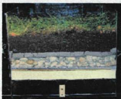
Рисунок 2.104 - Дерновая крыша в разрезе
