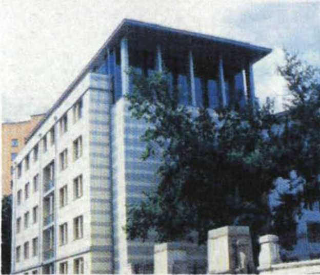
Рисунок 2.90 - Светопрозрачные ограждающие алюминиевые конструкции. Жилой дом по адресу: г.Москва, Зубовский проезд
