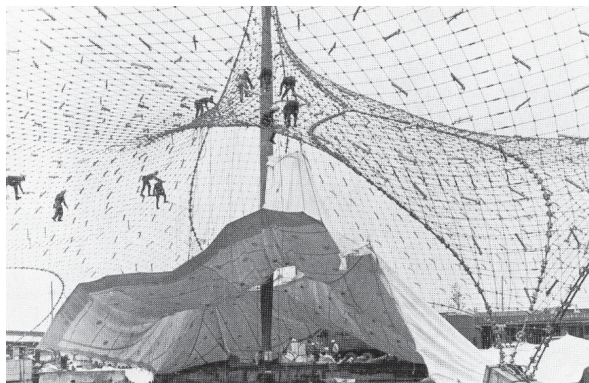
Монтаж оболочки из полихлорвинила, примыкающей к вантовой сети, для покрытия павильона ФРГ на Экспо-67.
