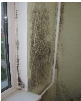
Грибок на обоях при недостаточной вентиляции
