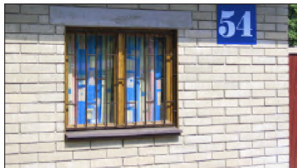
Рис. 4.19 Фрагменты стен зданий, выстроенных из грунтоблоков: а. - пример кладки из рядовых блоков; б - пример отделки здания фасонными блоками.
